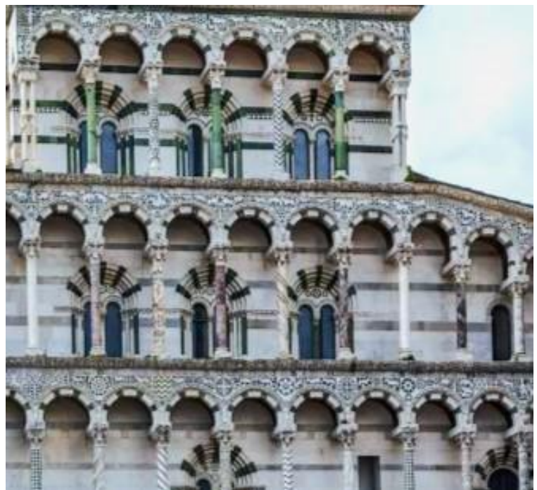
Marqueterie de marbre en haut de la façade du Duomo di San Martino (Lucca, Toscane)
