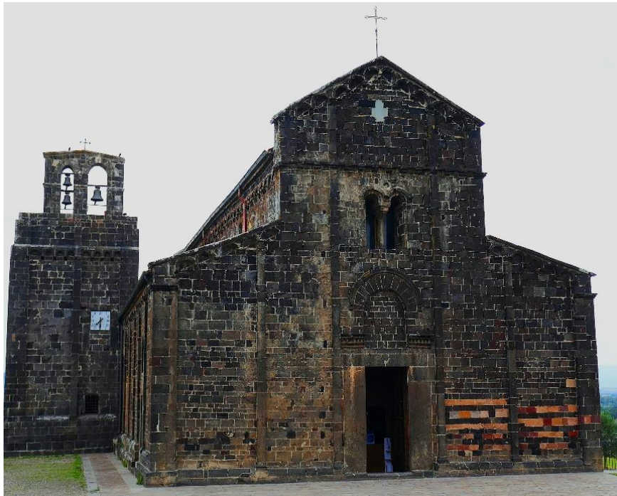
Le campanile de Nostra Dama del Regno, dont la partie d'en haut a dû céder la place à un simple peigne à la suite d'effondrements, est accolé à l'église mais bien séparé d'elle (Ardara, Sardaigne)
