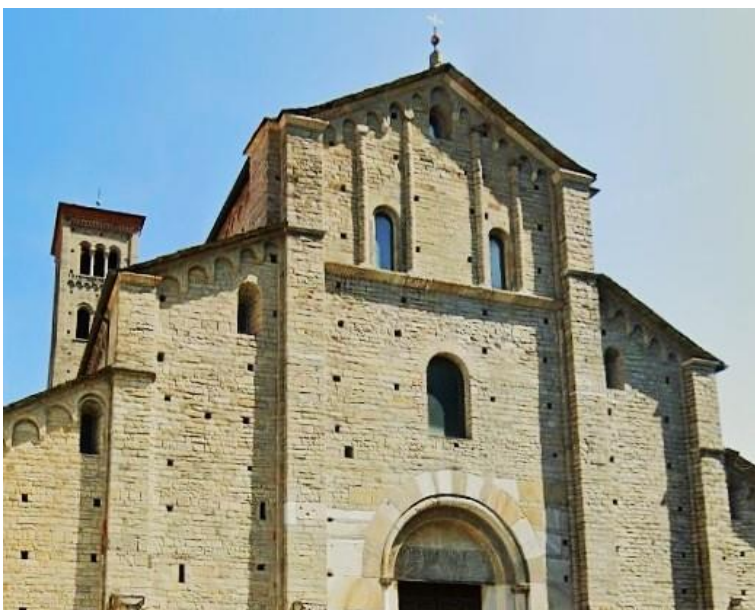
Como, Basilica di Sant'Abbondio
