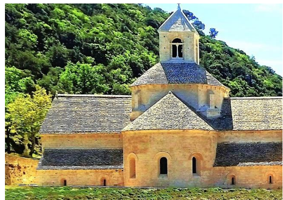
Tandis qu'une enveloppe pentagonale entoure l'abside centrale, les 4 absidioles ouvertes sur le transept ne se repèrent extérieurement que par leur petite baie (Sénanque, Provence 84)
