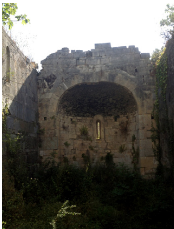
Fronton oriental et abside vus depuis l'intérieur de la nef
