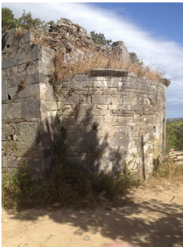
Façade orientale et abside
