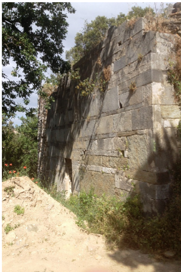
Mur méridional (parement extérieur)
